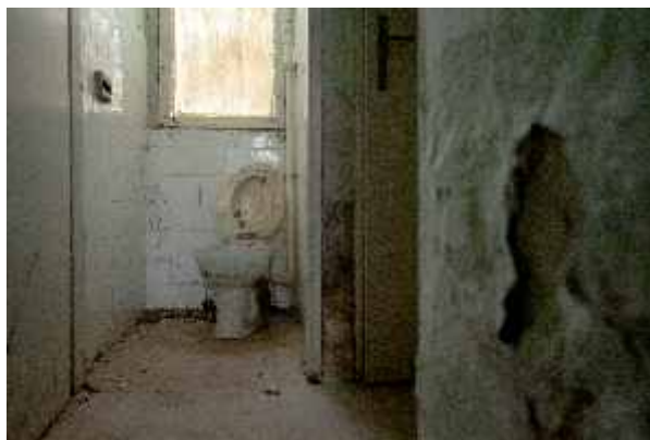
објекат пре реконструкције
