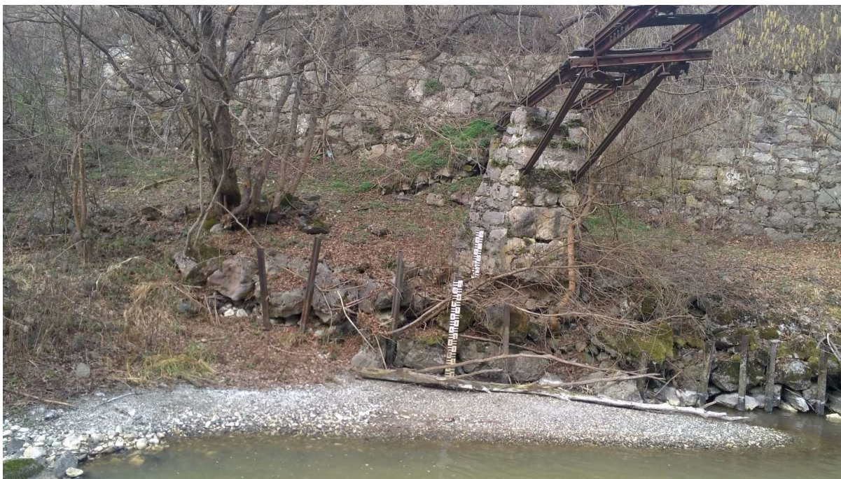
Слика 9. Локација старе хидролошке станице Стапари и водомерна летва
