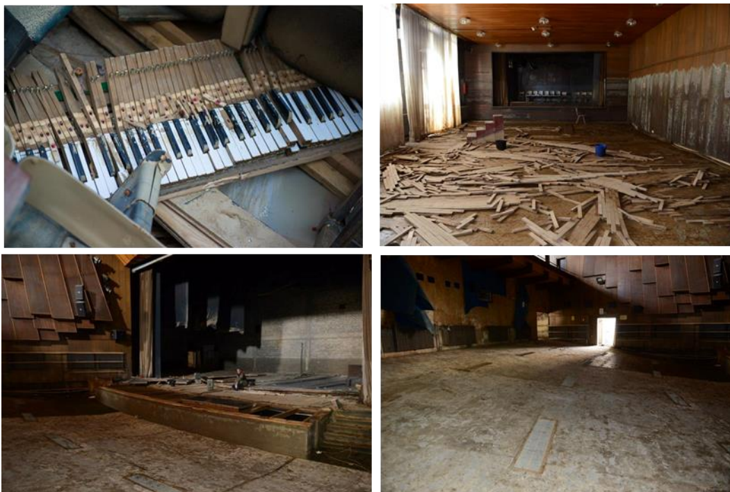
Слика 1-38. Културни центар у Обреновцу. Ситуација после повлачења воде. Слика у горњем десном углу приказује малу позоришну салу, линија поплаве је очигледна. Две доње слике приказују велику позоришну салу после уклањања седишта у партеру и штету која је причињена на систему ротационе позорнице.
